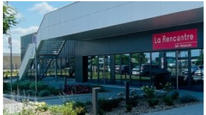
Accès principal par l'escalier extérieur
