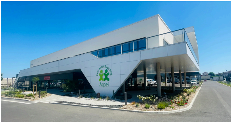
Entrée adaptée pour les personnes à mobilité réduite sous le porche
